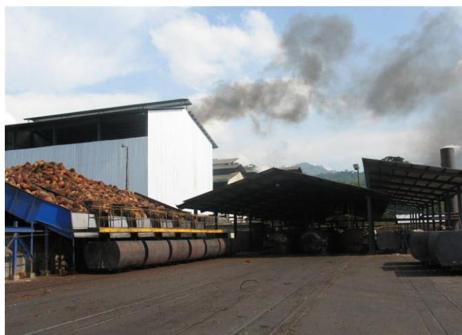
Planta extractora de aceite de Cukra Development Corporation—ubicada a tan solo 5 kilómetros de la finca.
