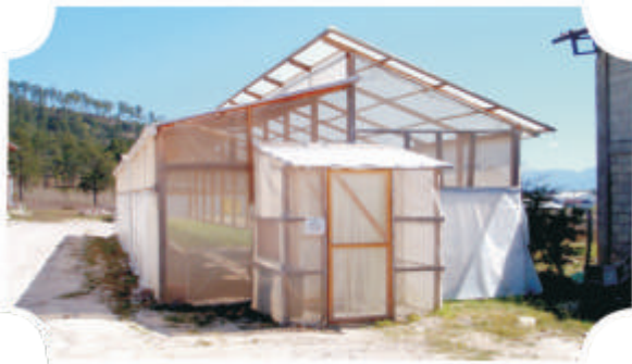
Foto 3. Invernadero convencional elaborado con madera y malla antivectores.
